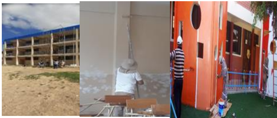
FOTO 1 Pintado de Ambientes, fachadas y etc. U.E.
