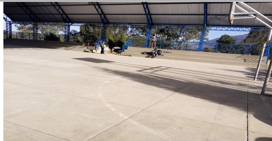
FOTO 4 Refacción de pintura en las canchas.
