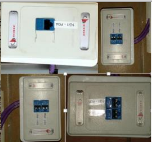
FOTO 7 Instalación De Tomas De Red De Datos Rj45 Y Aterramiento 35 Unidades Educativas
