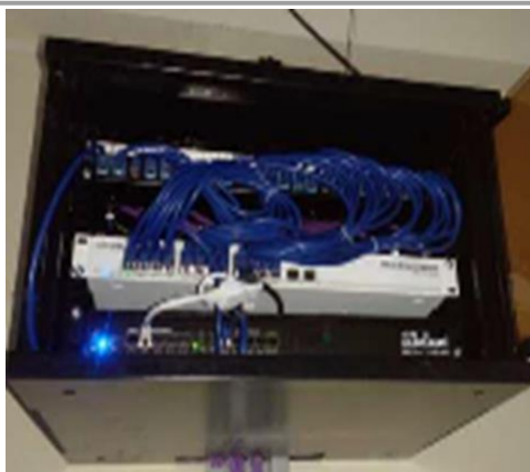
FOTO 5 Instalación De gabinetes con los equipos necesarios para la distribución del internet En 48 Unidades Educativas
