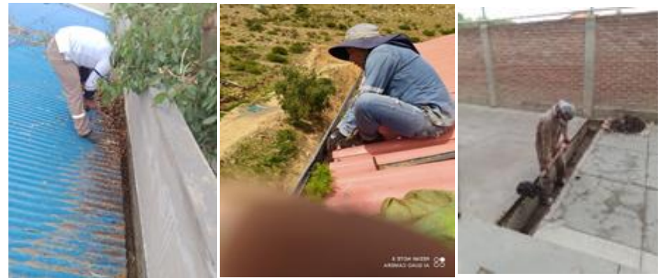
FOTO 2 Limpieza de Canaletas Bajantes y Canales de desagüe
